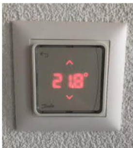
Thermostat dans le séjour et les chambres
